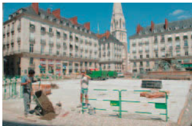
La pose du dallage est réalisée sur le tiers nord-ouest de la place Royale.
